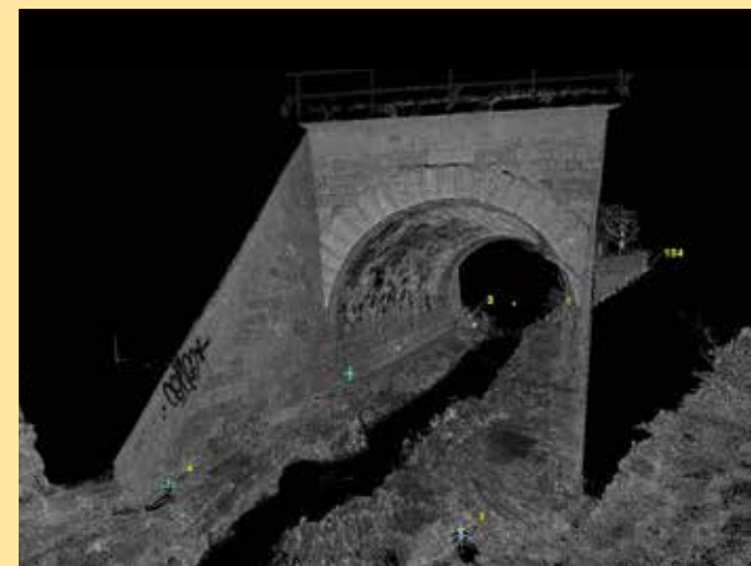
Téglaboltozat 3D lézerszkennerral készült képe
