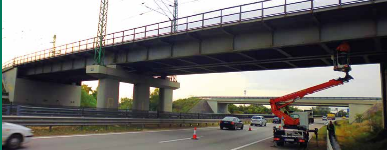
M0 autópálya híd szemrevételezéses vizsgálata
